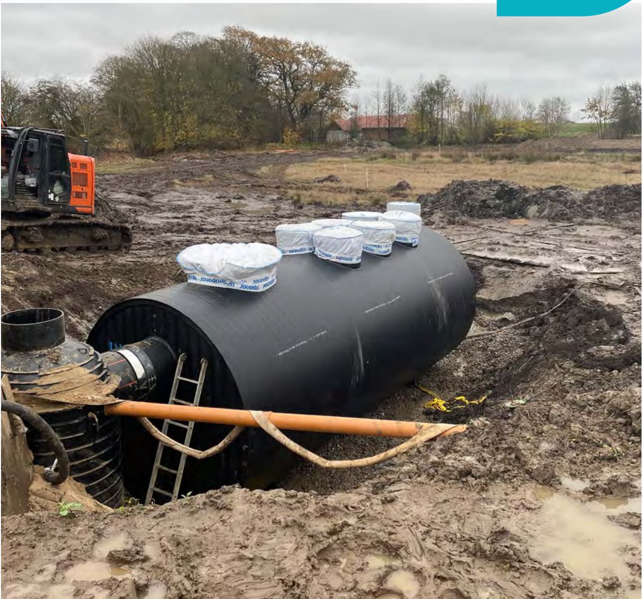
På billedet ses den specialdesignede Vault, som er den løsning vi har valgt til håndteringen af regnvand i Fremtidsparken.
