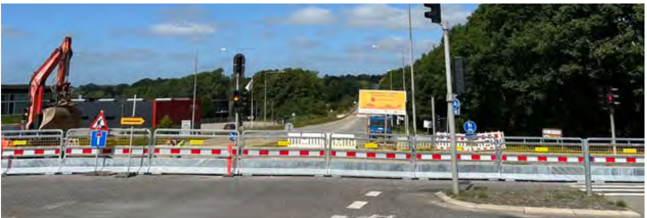
Separatkloakering af Rønde Hovedgade er et stort projekt, som forventes at vare ca. et år.
